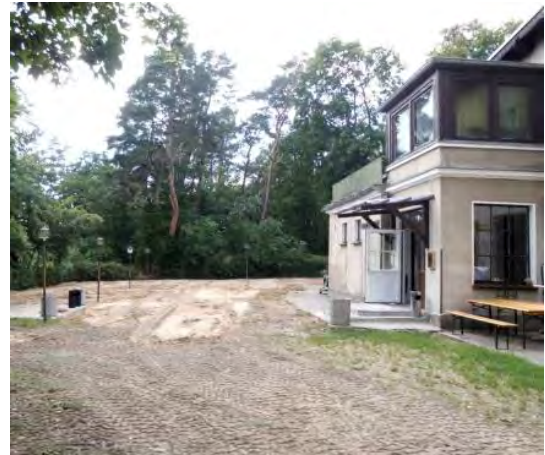
Sanierung Restaurant und Biergarten
