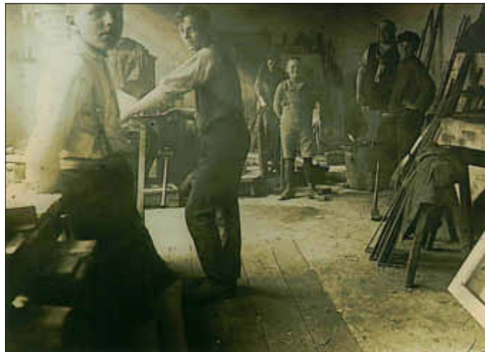
Ein Blick in die Werkstatt mit dem Meister am Schmiedefeuher, das den Qualm verbreitete.
