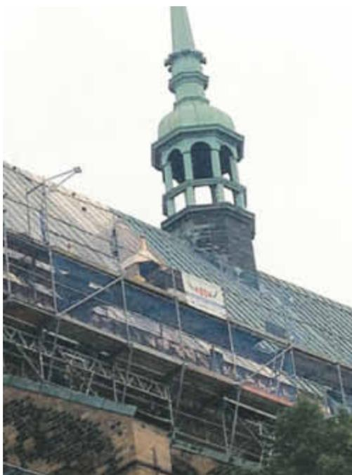
den 1970er Jahren verlegte Kupferdach und sorgt für gefährlichen Hausschwamm und morsche Balken. In diesem Jahr soll deshalb ein neues Kupferdach mit einer Dampfsperre und Lüftungsschlitzen verlegt werden. Auch diese Arbeit wird die Demminer Firma übernehmen, die bis jetzt gut die Hälfte des maroden Daches instand gesetzt hat. Und bei dem Ausblick über die Dächer von Stralsund macht die Arbeit allemal Spaß.
