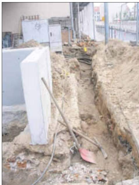
Sanierung der Außentreppe zum Eingang der Turnhalle der Heinrich-Zille-Schule.
