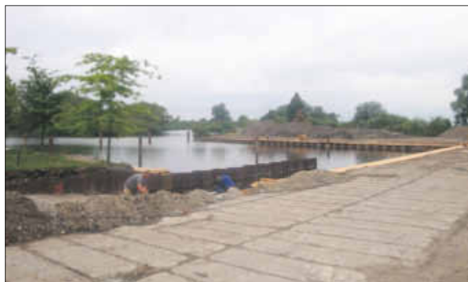
Der Neubau einer Marina in der Demminer Nikolaistraße schreitet mit großen Schritten voran.
