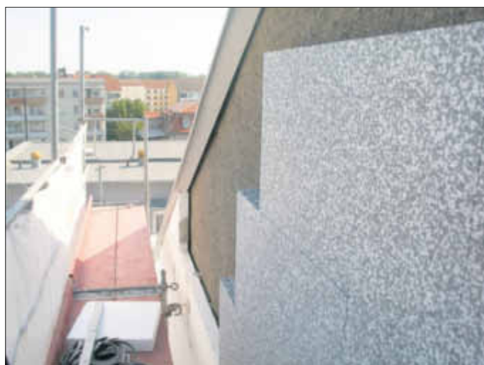
Die Heinrich-Zille-Schule, Haus II wurde komplett eingerüstet für eine wärmetechnische Sanierung der Fassade. Der alte Putz entfernt. Straßen- und Hofseitig wurde Wärmedämmputz auf das freiliegende Mauerwerk aufgetragen und farblich behandelt. Giebelseitig wurden Wärmedämmplatten im Verbundsystem angebracht
