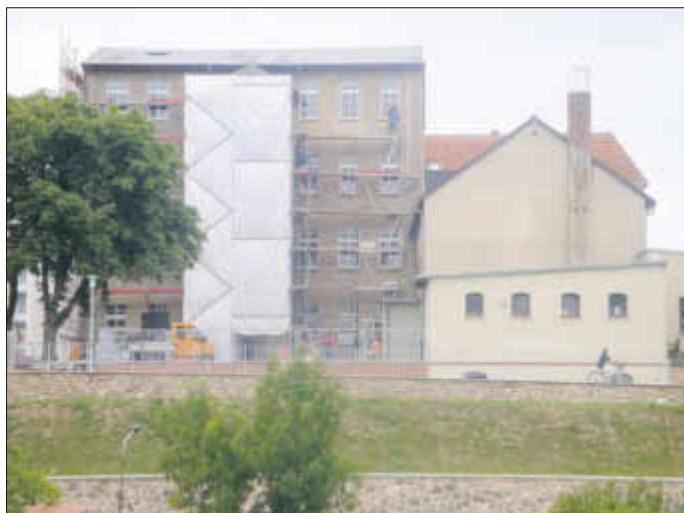
Die Heinrich-Zille-Schule, Haus II wurde komplett eingerüstet für eine wärmetechnische Sanierung der Fassade. Der alte Putz entfernt. Straßen- und Hofseitig wurde Wärmedämmputz auf das freiliegende Mauerwerk aufgetragen und farblich behandelt. Giebelseitig wurden Wärmedämmplatten im Verbundsystem angebracht
