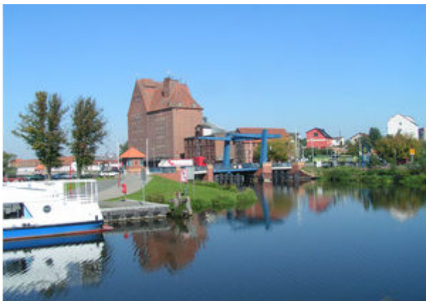
Die Kahldenbrücke - eine Klappbrücke über die Peene Fotos: Internetseite der Hansestadt Demmin
