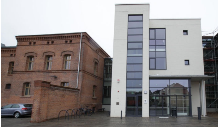
Clara-Zetkin-Straße 14 Hofgebäude nach der Sanierung und neu gebauter Mittelbau
