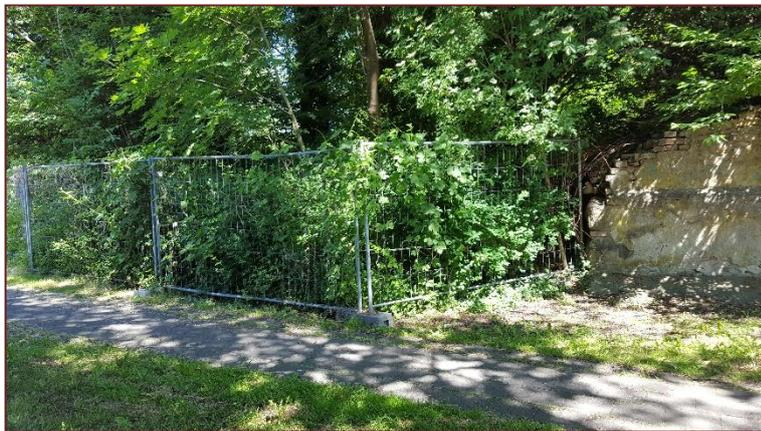
m NHN bis in den flachen Bereich der Mühlengrabenpromenade mit +1,05 m NHN ist zur Sicherung des Hochwasserschutzes die vorhandene Feldsteinmauer/ Ziegelsteinmauer zu verlängern, um eine direkte Verbindung zwischen den offenen Mühlengraben und der Mühlengrabenpromenade zu unterbinden. Folge wäre ansonsten, dass
