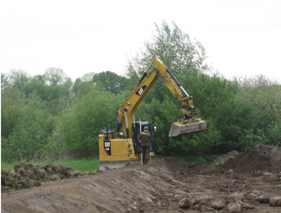
16.05.2018 _ die ersten Dämme für das Spülfeld entstehen (Bild: F. Rose)
