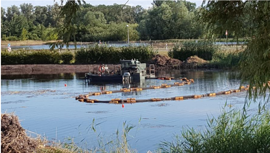
26.06.2018 _ die Technik der Fa. BSD Baustoff und Gewässersanierung GmbH Dessau - Roßlau im Einsatz (Bild: L. Janssen)
