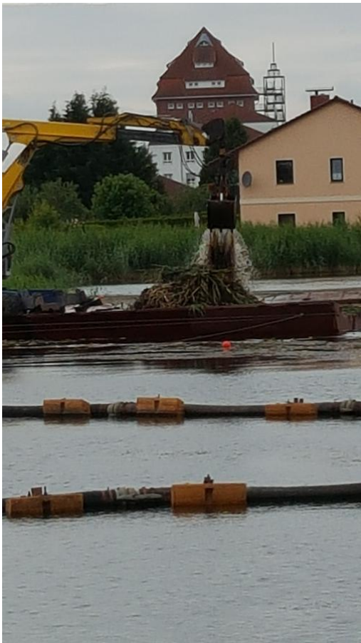
11.06.2018 _ Beräumung der Teichsohle sowie der Ufervegetation (Bild: L. Janssen)
